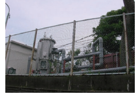
図3 高濃度酸素水生成装置
