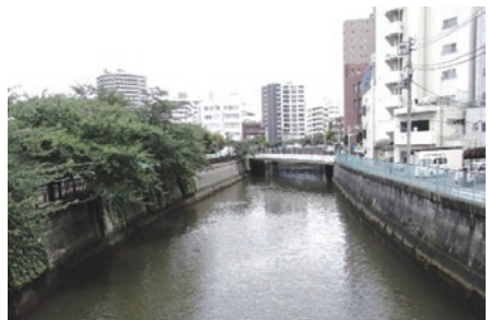
図1 呑川 御成橋より下流を望む(平成21年7月撮影)
