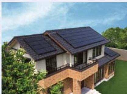
CIS太陽電池の国内設置事例 (ソーラーフロンティア株式会社 提供)
